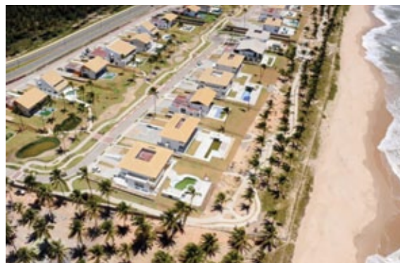
Condomínio na Reserva do Paiva, que com a implantação do FTTH obteve uma aparência extremamente limpa, valorizando o imóvel
