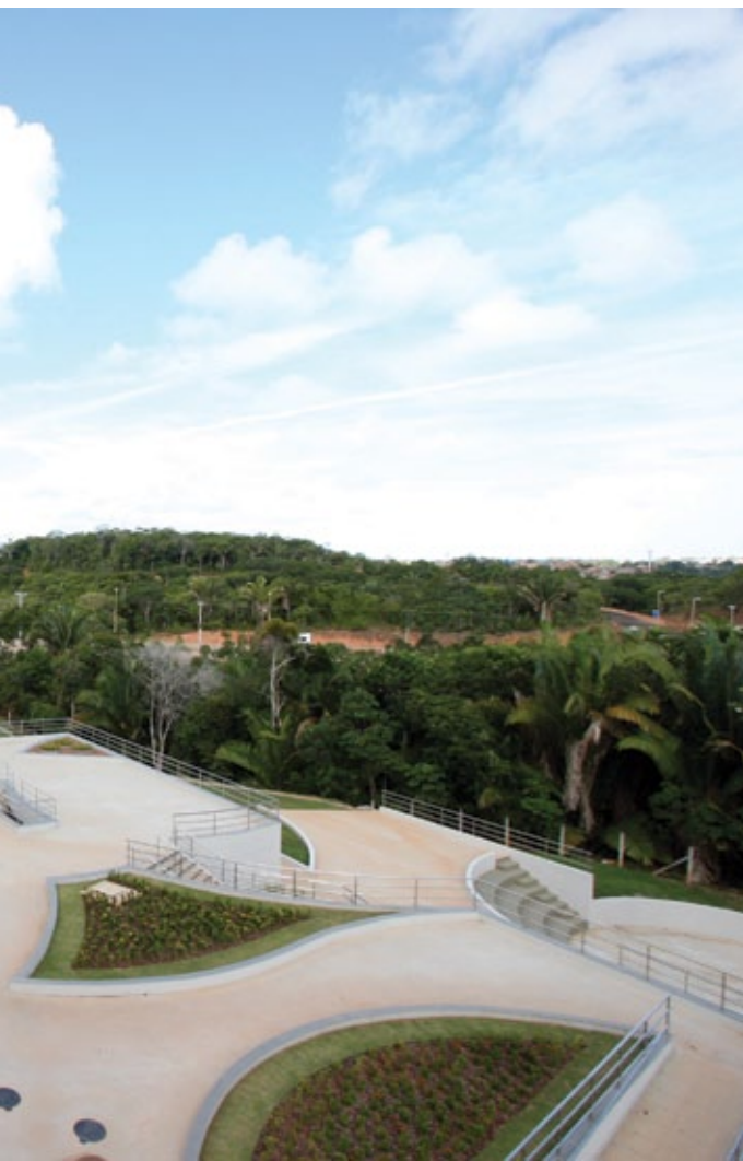
Implantação do Parque Tecnológico da Bahia será feita em três etapas. A primeira, que compreende o Tecnocentro, entrará em atividade em setembro de 2012
