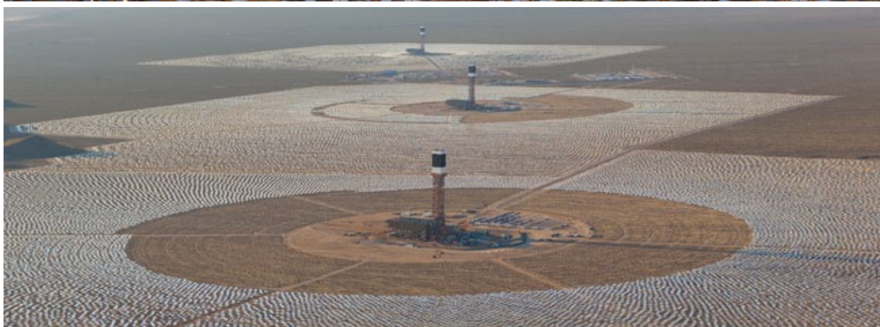
O Ivanpah Solar Electric Generating System, na Califórnia (EUA), pertencente à NRG Energy, BrightSource Energy e Google, é hoje considerada a maior usina solar do mundo. A usina americana reúne 300.000 espelhos com 2 m de altura e 3 m de largura. Eles são controlados por computador, focalizando a luz do Sol até o topo de torres com 140 m de altura. Nelas, a água se transforma em vapor para mover turbinas de energia. A usina se estende por um terreno de 13km 2 , próximo a fronteira entre Nevada e Califórnia e produz energia suficiente para mais de 140 mil casas nos Estados Unidos
