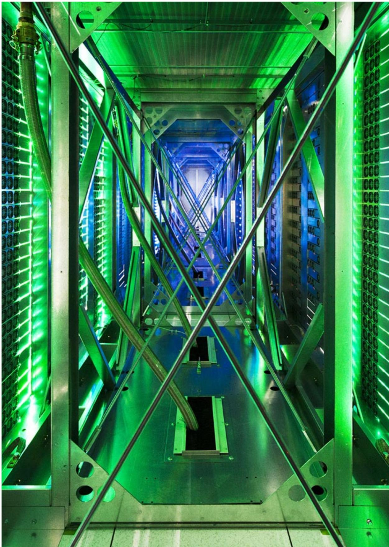
Ventiladores (localizados atrás dos servidores) do Google no estado de Iowa, nos EUA. Eles canalizam o ar quente dos racks. A luz verde é reflexo dos LEDs de status do servidor
